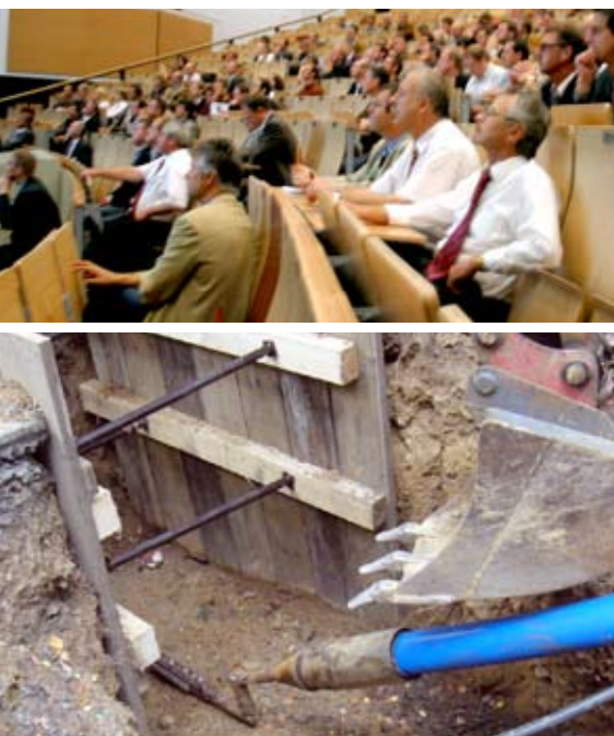
Einziehen des Berstkörpers und des Neurohres
