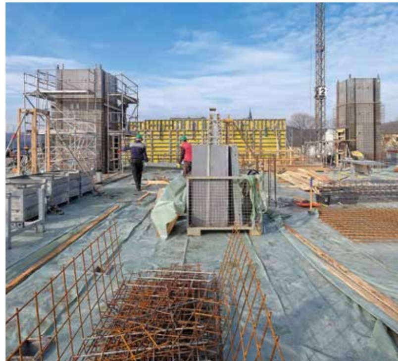
Im Obergeschoss steht man aktuell noch unter freiem Himmel mit schönem Blick über die Dächer der Stadt. Wände und Decken werden in den kommenden Wochen errichtet.
