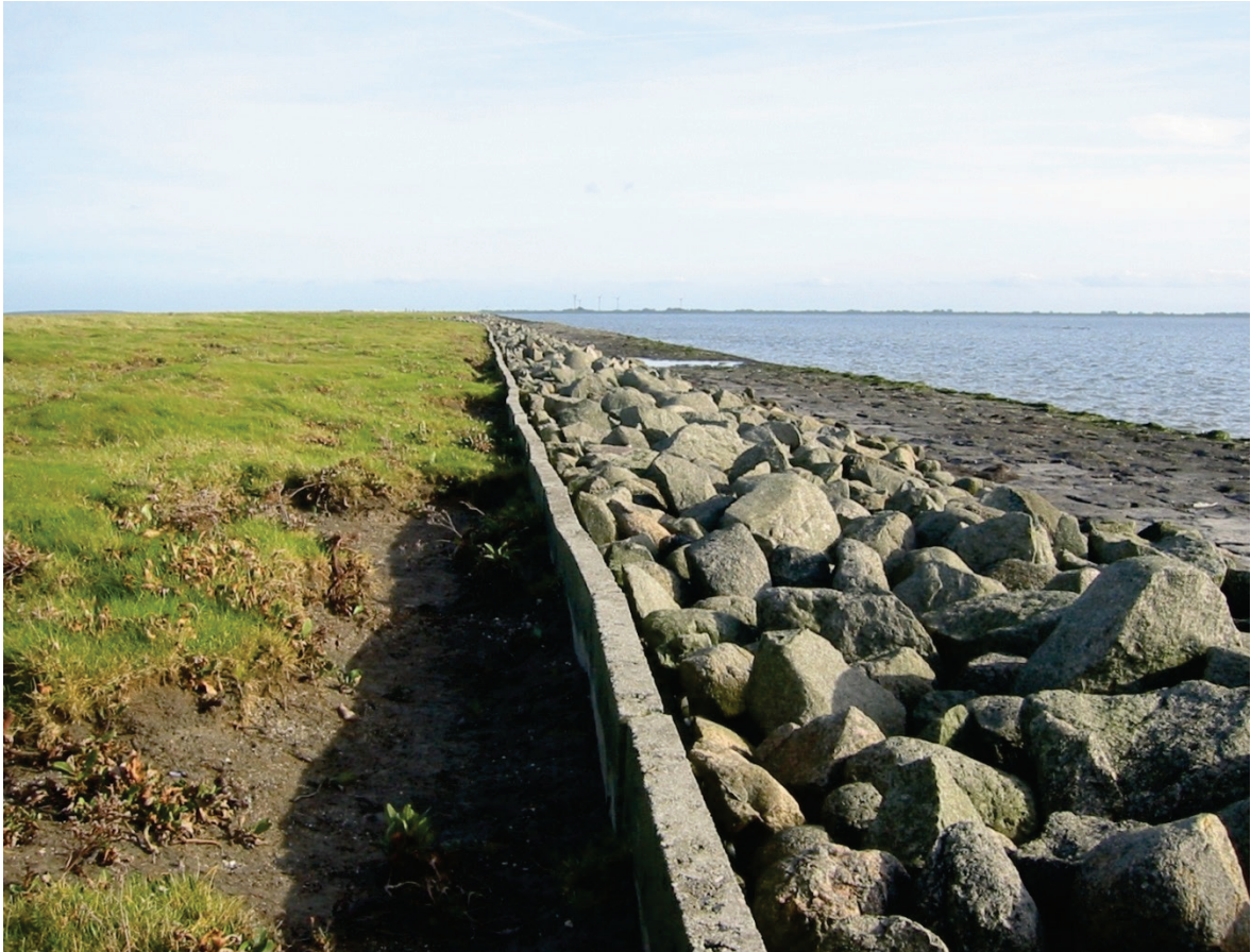
Abbildung 6 Alter Rauhstreifen auf Nordstrandischmoor. Das Niveau der binnenseitigen Salzmarsch wächst über die Höhe des Rauhstreifens hinaus. Foto: Schindler 2012.
