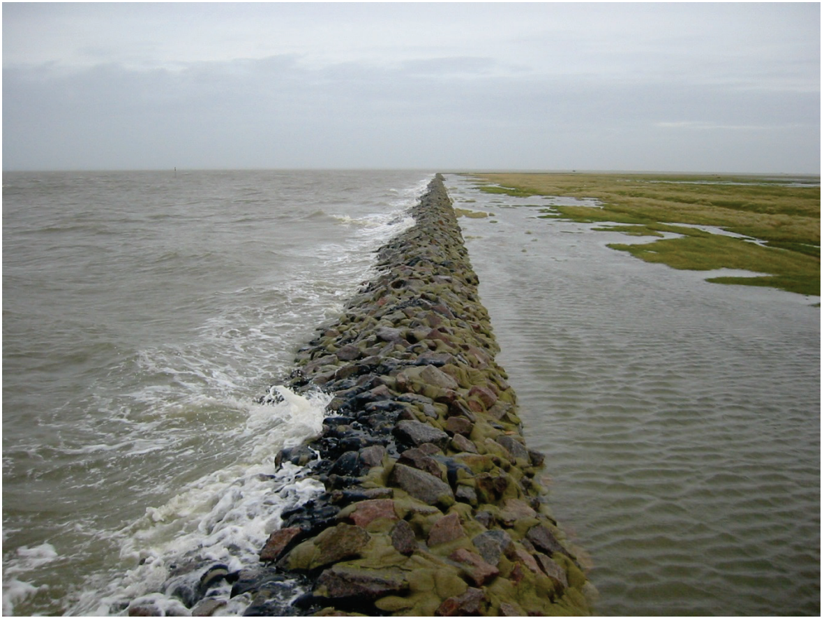
Abbildung 4 Konservativer, wasserdurchlässiger Rauhstreifen (Halligigel) auf Nordstrandischmoor. Foto: Schindler 2011
