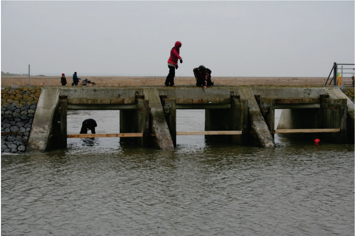
Abbildung 10 Die drei Flügeltore der Sielanlage am Osterwehl sind mittels Balkensperren für den Zeitraum der Freilandmessungen fixiert.
