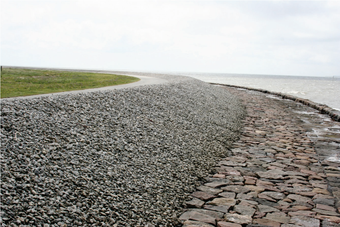
Abbildung 5 Moderner wasserdurchlässiger Halligigel auf Langeneß. Schotter wird mittels eines Zwei-Komponenten-Klebers (Elastocoast®, BASF) zu einem Rauhstreifen modelliert. Dem Igel vorgelagert eine wasserundurchlässiges Pflaster aus Blöcken. Foto: Deicke 2014
