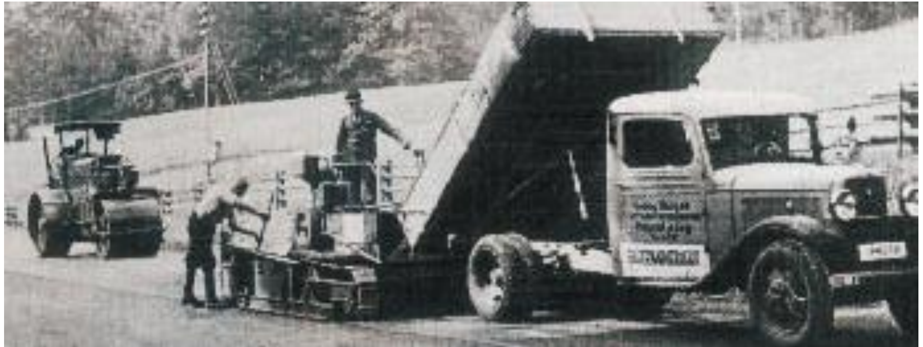
Diesel-mechanisch angetriebener Straßenfertiger, Baujahr 1938
