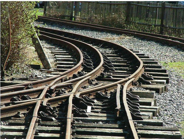
Dreischienengleis für Züge mit verschiedenen Spurweiten
