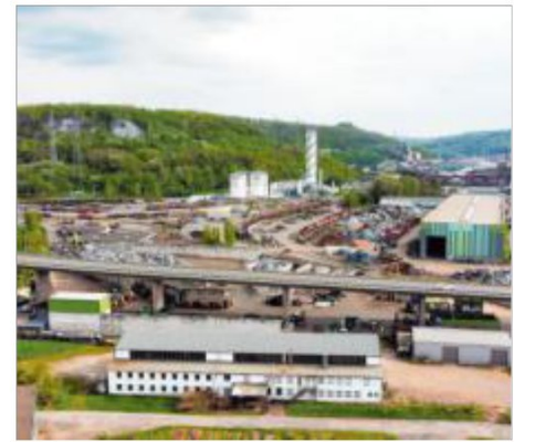
50 Jahre nach ihrem Bau hat die „Setzer Brücke“ Federn gelassen. Foto: Kay-Helge Hercher
