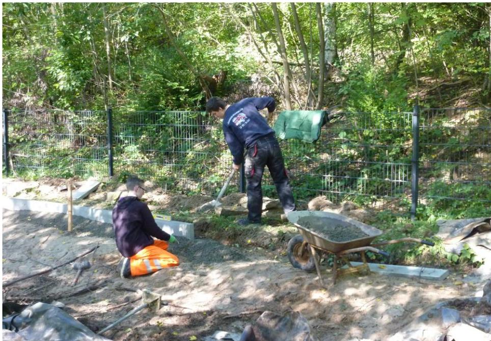
Abb. 7: Die Randsteine werden waagrecht verbaut und mit Rückenstützen versehen
