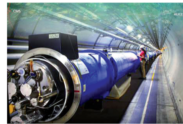
Blick in den LHC-Tunnel mit seinen Beschleunigerkomponenten
