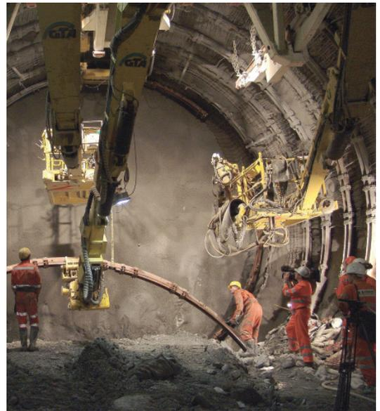
Abb. 4: Konzept der deformierbaren Stahlringe [Bild: © AlpTransit Gotthard AG.]
