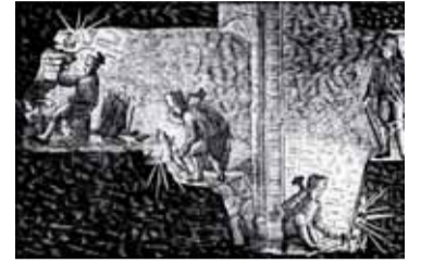
Bergbau im Siegerland auf einer zeitgenössischen Darstellung um 1800: Strossenbau auf der Grube Viktoria bei Littfeld.
