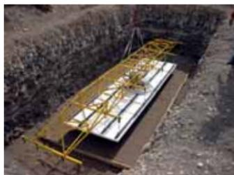
Noch sind die neun Meter langen Szintillatoren begehbar, die die Ausleseelektronik tragen. Jeweils drei Szintillatoren werden in zwei Metern Tiefe um einen Wassertank gruppiert.
