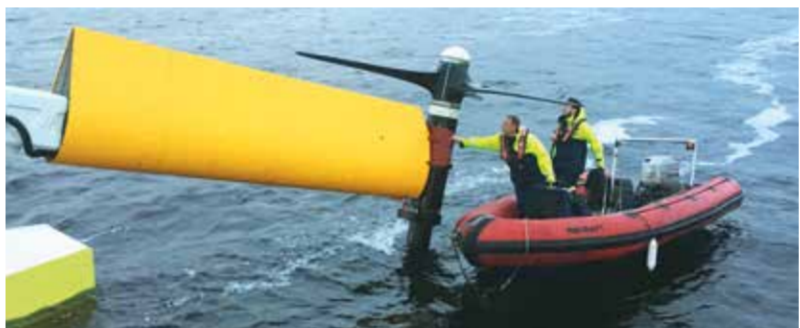
Die Wartung der kleinen Turbinen ist ohne Taucher möglich.
