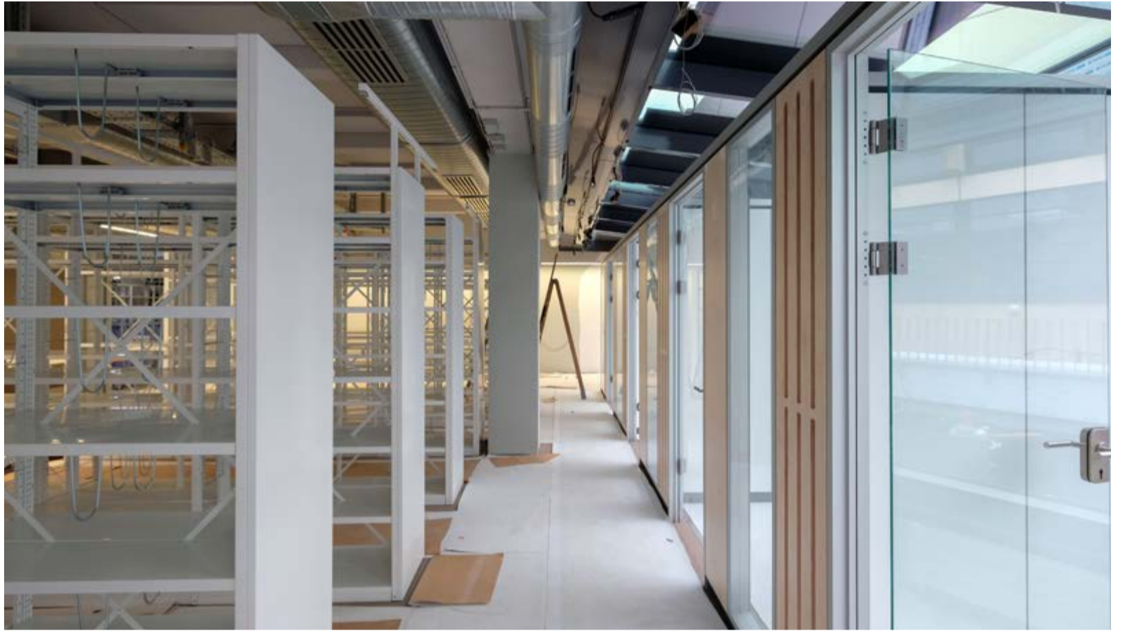
Auch wenn die Böden noch abgeklebt sind, lässt sich schon erahnen, wie es in der UB künftig aussieht: Hell und freundlich soll die „neue“ Bibliothek werden, zum Arbeiten gibt es neben Gruppen- auch Einzelräume, wie hier rechts zu sehen.
